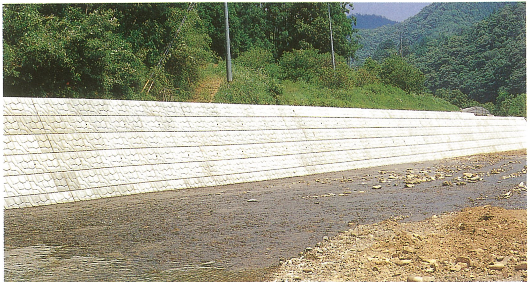
[河川災害復旧工事]高知県西土佐村・高知県土木部
