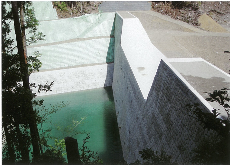
〔宮川水系春日谷川砂防激甚災害対策特別緊急工事〕 三重県・松阪建設事務所
