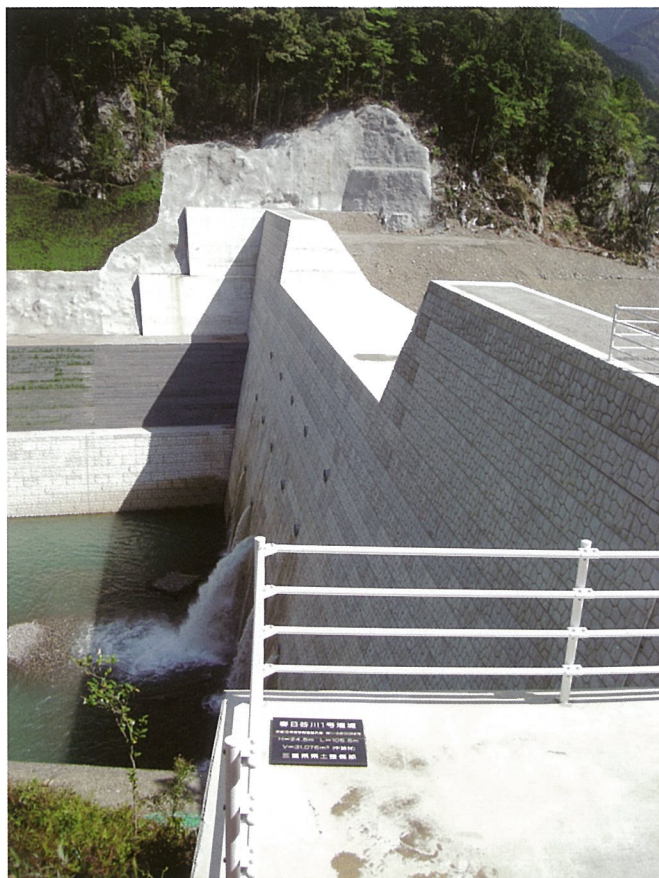
〔宮川水系春日谷川砂防激甚災害対策特別緊急工事〕 三重県・松阪建設事務所
